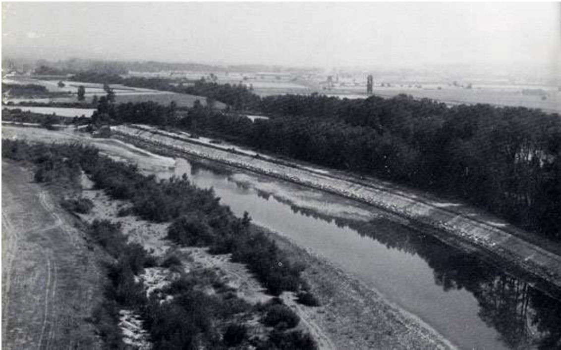
Fig. 49 – Vista aerea dell’inalveamento (fonte: AdBPo).
