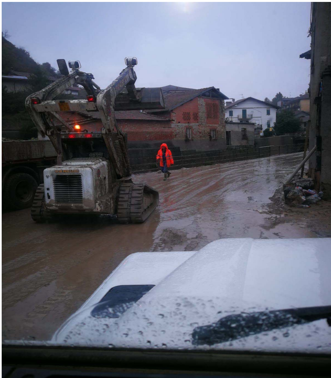
Attività di ripristino nel Comune di Castelletto d'Orba (AL)
