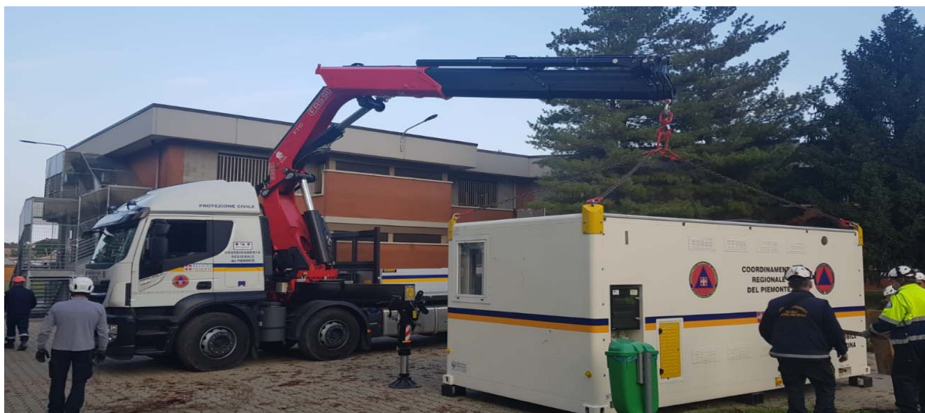
Fasi di montaggio della cucina mobile da campo
